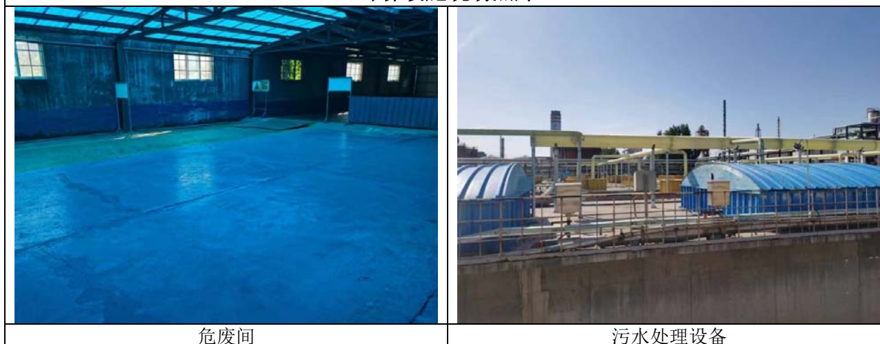
环保设施现场照片
